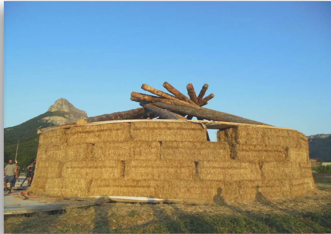
Edificio de balas jumbo en EkoKamping Arbizu, Navarra
